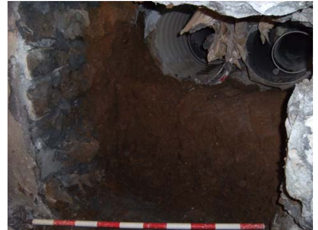
FOTO 4. Vista de detall del forat de connexió del clavegueró amb la xarxa municipal de clavegueram.
