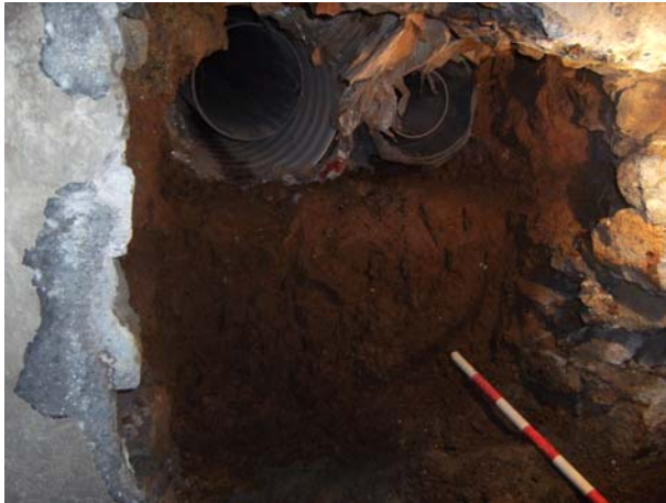
FOTO 3. Vista de detall del forat de connexió del clavegueró amb la xarxa municipal de clavegueram.
